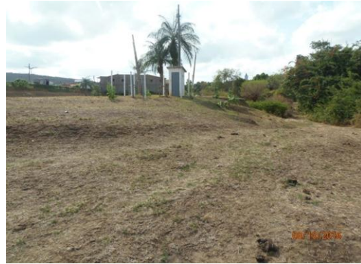
Figura 16.2 – Ponto de erosão considerável no final do trecho (próximo ao ponto 3)
