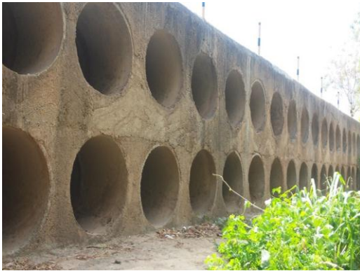
Figura 13.3 – Passagem molhada construída no leito com sistema de drenagem por manilhas
