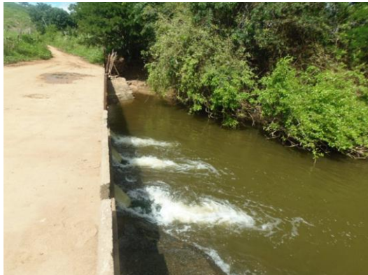
Figura 16.4 – Passagem molhada construída com sistema de manilhas.
