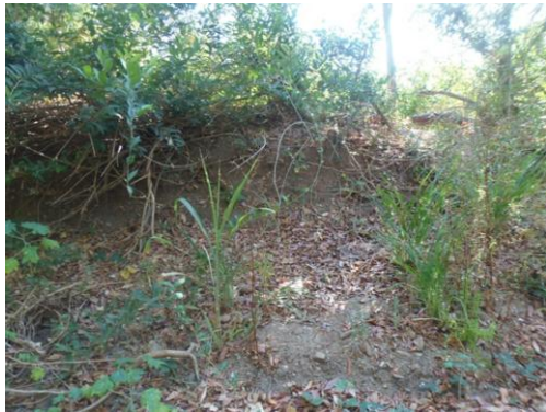
Figura 14.1 – Erosão da margem menor
