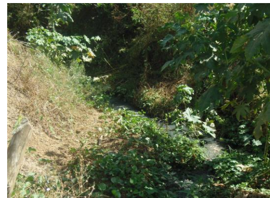
Figura 16.6 – Rede de esgoto desaguando nesta margem sem nenhum tratamento
