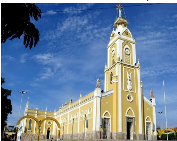
Figura 28: Basílica de Nossa Senhora das Dores: construída pelo Padre Cícero em 1875
