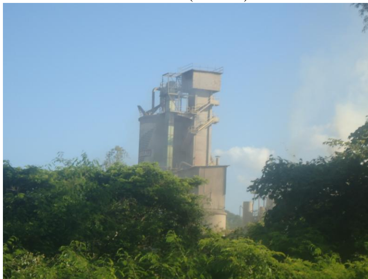
Figura 55: Poluição atmosférica causada pela Indústria Barbalhense de Cimento Portland (IBACIP).
