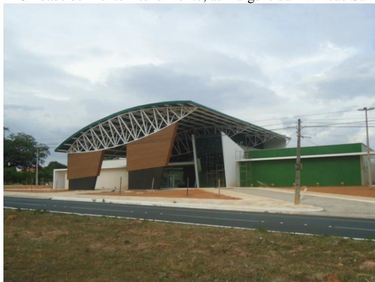
Figura 22: UPA – Unidade de Pronto Atendimento, as margens da Av. Leão Sampaio, Barbalha.
