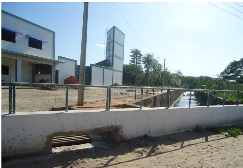
Figura 59: Ocupação irregular da área do Parque Ecológico na Av. Castelo Branco (sudoeste) Juazeiro do Norte – Ce.
