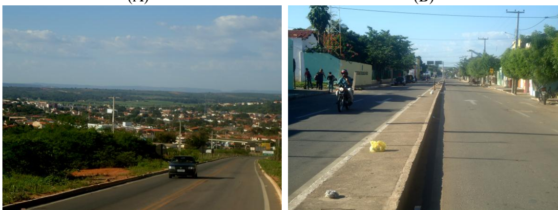
Figura 18: (A) Entrada da cidade acesso ao distrito do Caldas; (B) Av. Paulo Maurício. (A) (B)
