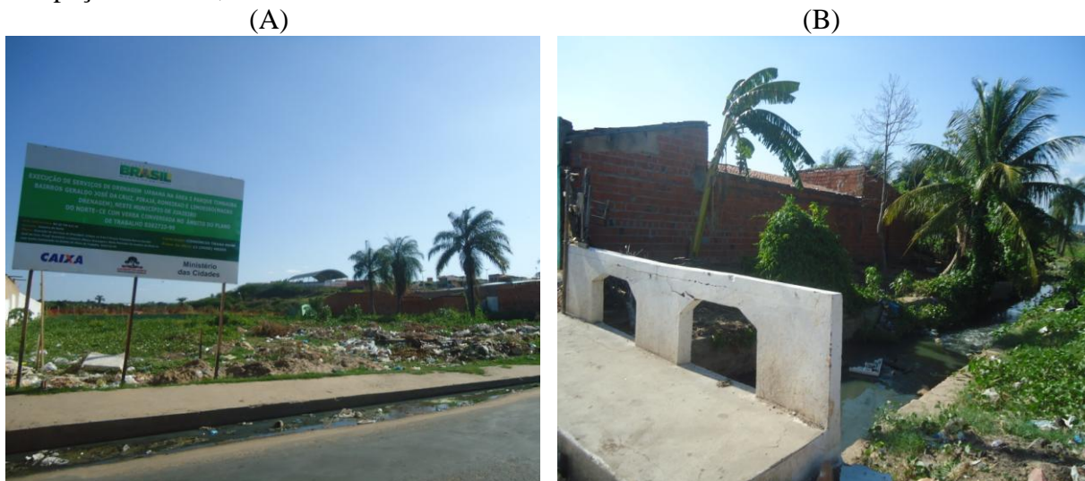
Figura 61: (A) Poluição de recursos hídricos com destinação inadequada de resíduos, (B) Ocupação de risco, Av Rui Barbosa Juazeiro do Norte.
