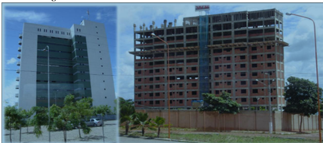
Figura 38: Edifícios comerciais e residenciais em Juazeiro do Norte
