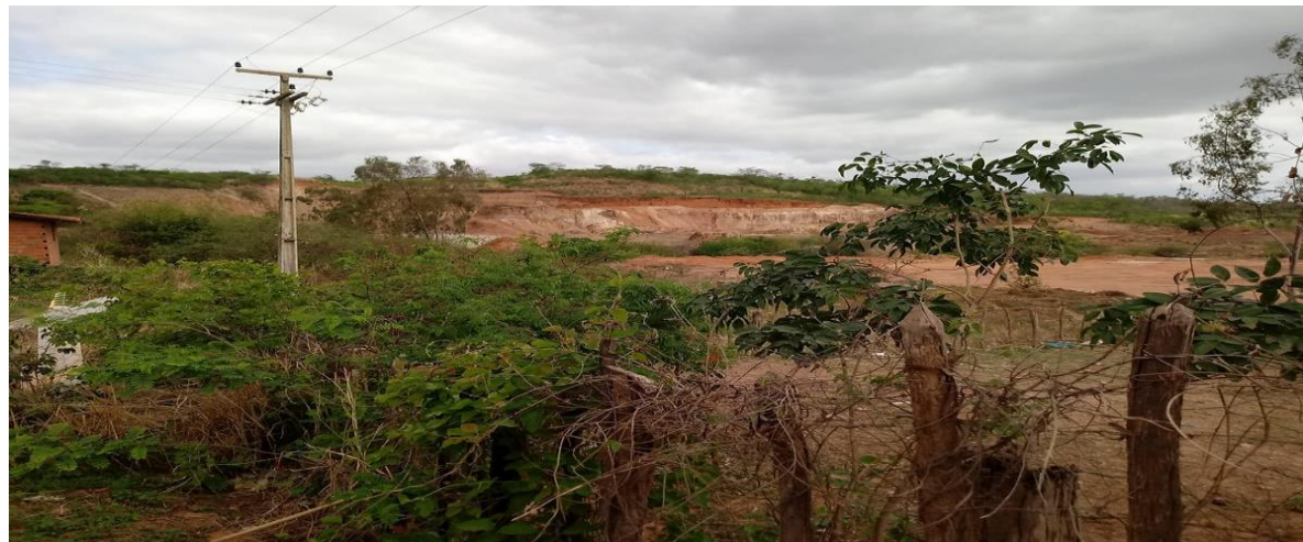
Foto 3- Trecho onde passará o Canal da Integração na Comunidade da Lagoinha ao lado do Lixão da Cidade de Crato - 2017
