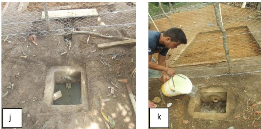
**Figura 6 – Etapas de construção das Fossas Verdes: (a) e (b) Escavação de valas; (c) Impermeabilização do piso; (d) Fossa totalmente impermeabilizada; (e) Construção da pirâmide de tijolos; (f) Pirâmide totalmente construída; (g) Camadas de entulho (restos de tijolos); (h) Camada de cascas de coco secas e de babaçu; (i) Camada de solo; (j) Caixa receptora de águas cinzas; (k) Caixa receptora de água da cisterna.**
