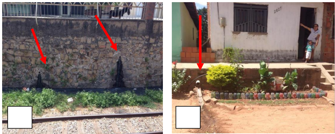
Figura 17 - Esgotamento sanitário na cidade de Juazeiro do Norte-Ce. (A) Esgoto sendo lançado na faixa de domínio da linha férrea no bairro Franciscanos. (B) e (D) Esgoto a céu aberto em residências no bairros São José e na rua Domingos Sávio. (C) Acúmulo de águas cinzas provenientes de esgotos domésticos no bairro Timbaúbas.
