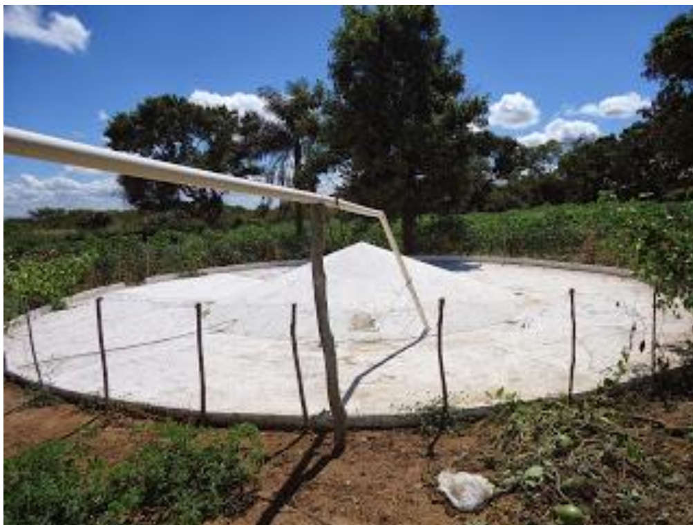
Figura 3: Cisterna calçadão circular, popularmente Chapéu do Pe. Cícero
