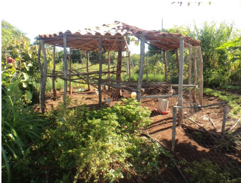
Figura 12: Sistema PAIS instalado na comunidade Oitis, município de Milagres -CE
