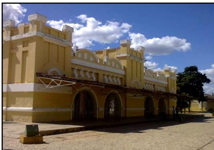
Figura 20 – Estação Ferroviária (2014) atualmente conhecida por Largo da RFFSA (Rede Ferroviária Federal S.A)
