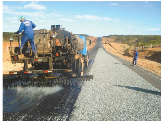
O TRECHO DA NOVA rodovia, na altura da BR-230, já conta com asfalto. DER prevê para o primeiro semestre de 2011 a conclusão da estrada que vai trazer melhorias ao Cariri. FOTOS: ELIZÂNCIA SANTOS
