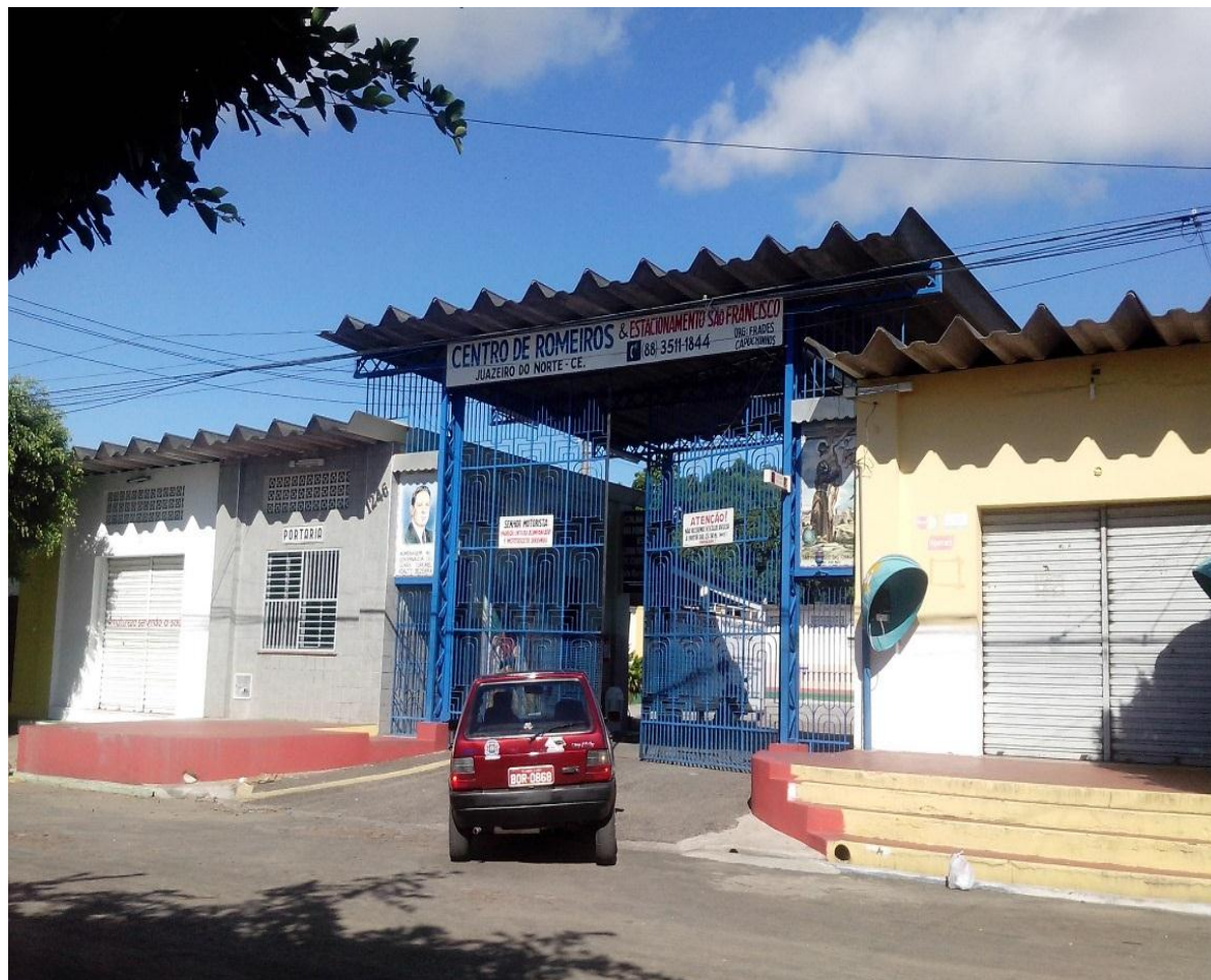
FIGURA 23 – Centro de Romeiros, Localizado na Rua Pimpim Almeida, Bairro Franciscanos, em Juazeiro do Norte - CE
