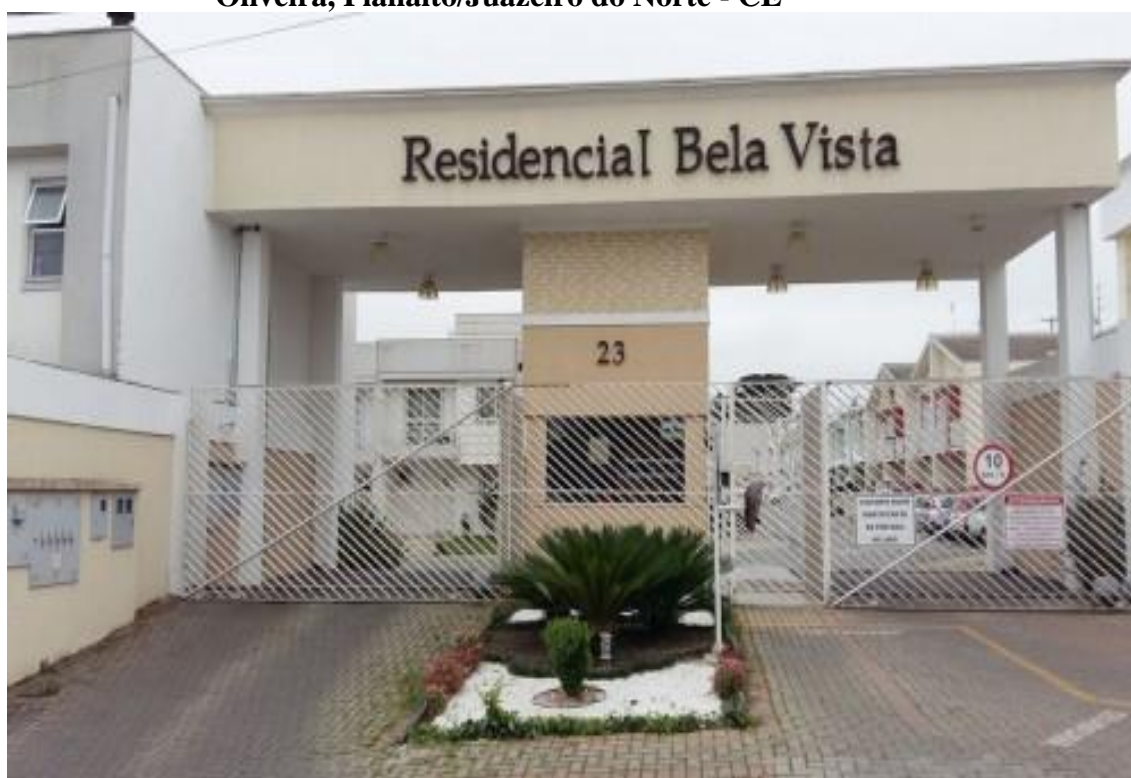
FIGURA 13 – Condomínio Residencial Bela Vista, Rua José Augustinho Oliveira, Planalto/Juazeiro do Norte - CE
