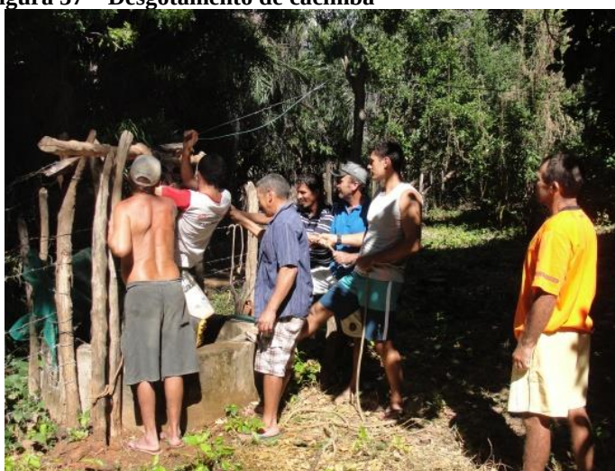
Figura 37 – Desgotamento de cacimba
