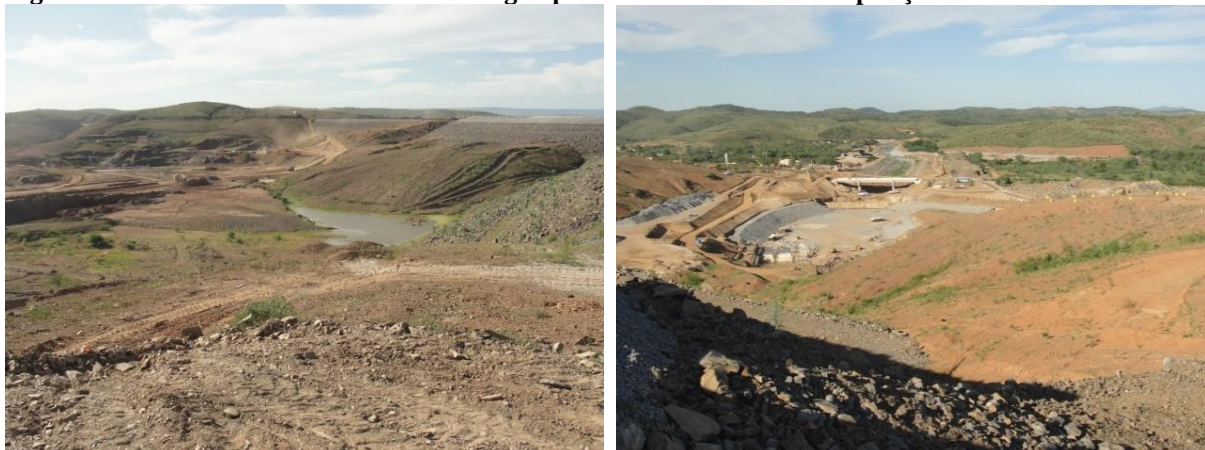
Figura 8 e 9 – Reservatório Jati e saída da água para o Eixo Norte da transposição
