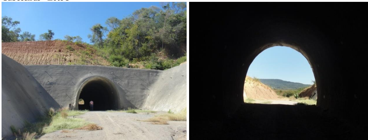
Figuras 14 e 15 – Túnel Cabeceiras em Barbalha sob a APA Araripe e vista a partir do interior do Túnel Cabeceiras - Lote 3
