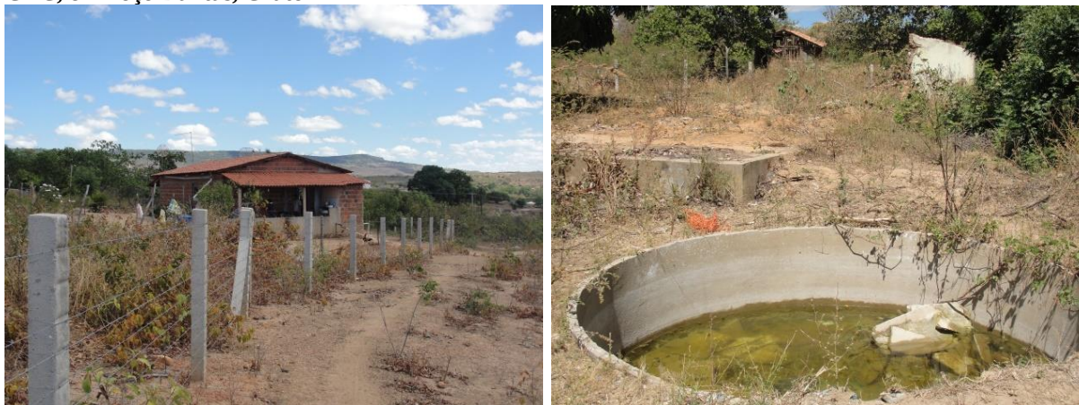
Figuras 27 e 28 – Cerca delimitando o CAC ao lado de uma casa e cisterna destruída para execução do CAC, em Poço Dantas, Crato
