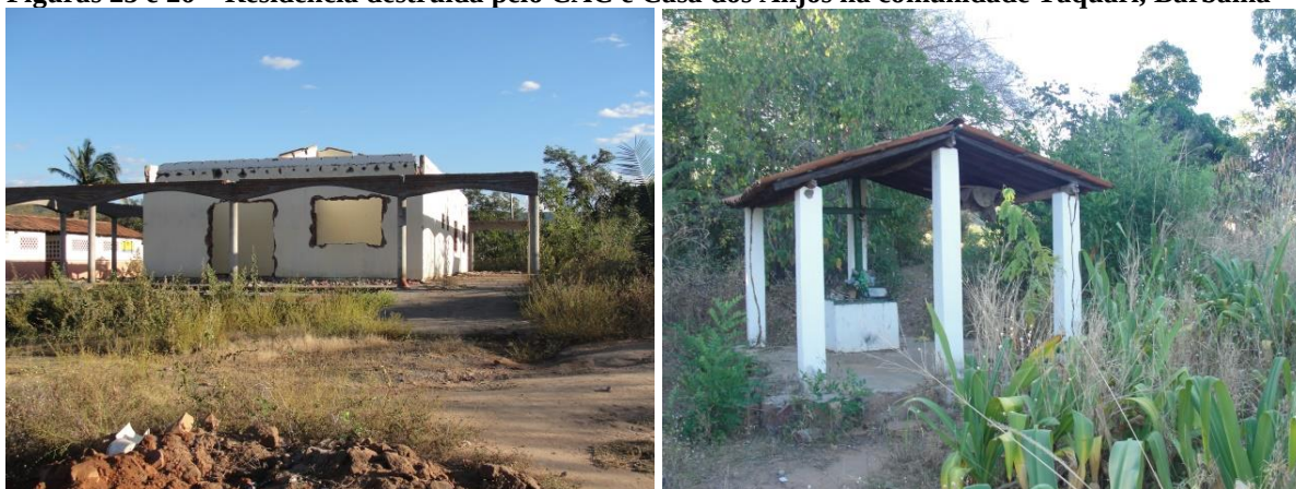
Figuras 25 e 26 – Residência destruída pelo CAC e Casa dos Anjos na comunidade Taquari, Barbalha
