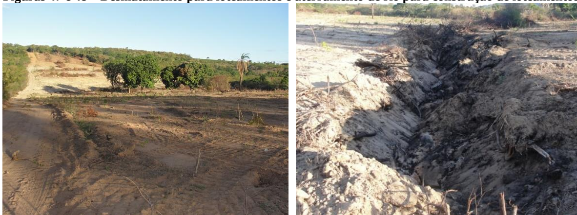
Figuras 47 e 48 – Desmatamento para loteamentos e aterramento de rio para construção de loteamentos
