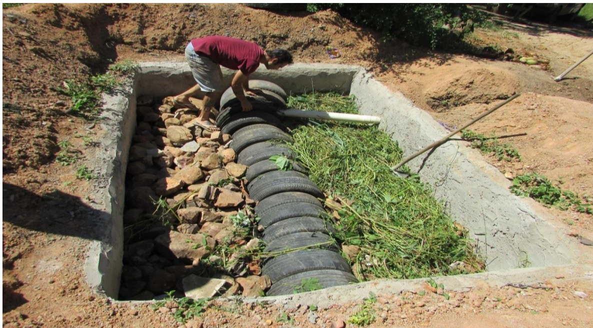
Foto 03 – Construção da fossa séptica ecológica no Assentamento 10 de Abril
