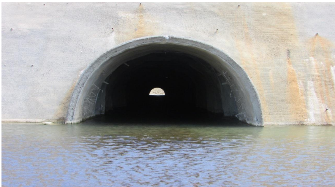
Foto 04 – Túnel: obras do cinturão das águas no Assentamento 10 de Abril
