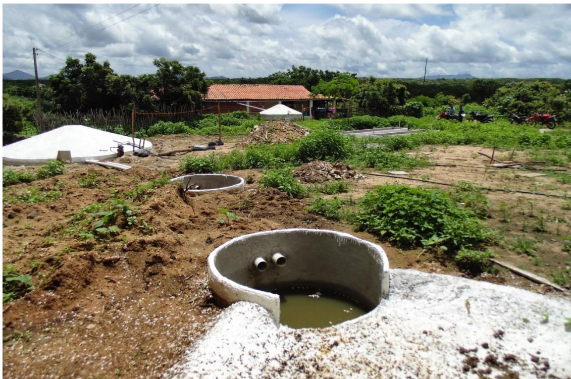
Figura 3 - Cisterna Enxurrada
