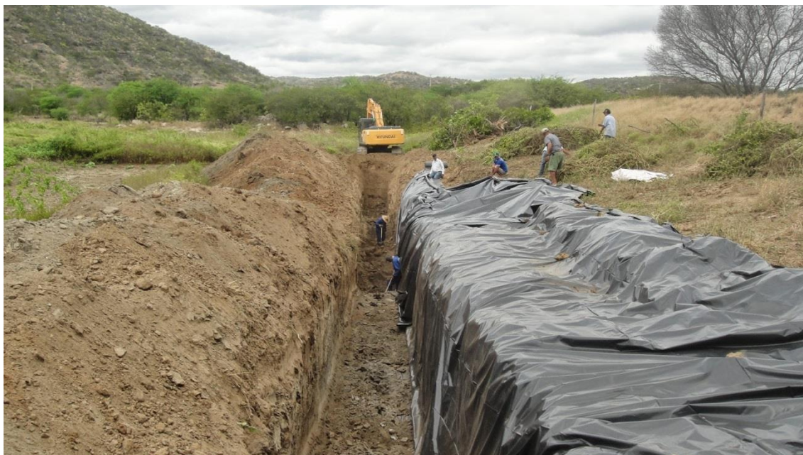
Figura 6 - Barragem Subterrânea
