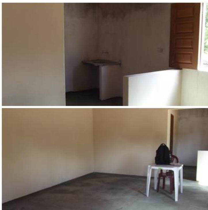
Figura 10. Destaque para o interior da Casa de Sementes L.S.A da Serra do Catolé.
