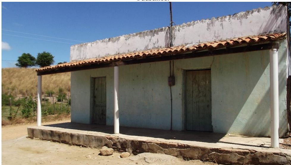
Figura 26. Prédio em que a Casa de Sementes Santa Inês funcionava, comunidade Lagoa dos Faustinos.
