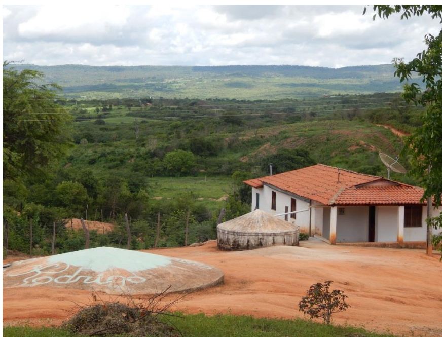
Figura 33- Utilização de cisternas na Região do Cariri
