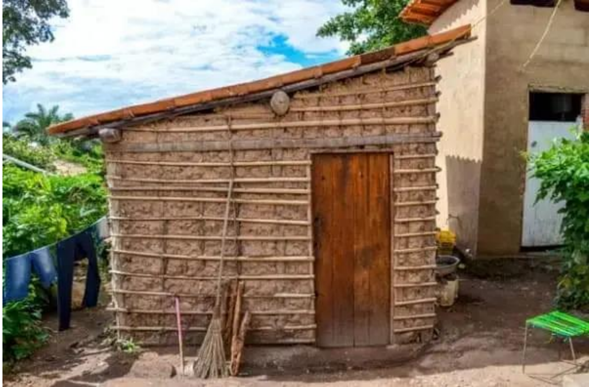
Figura 13 - Casa Construída em Taipa.
