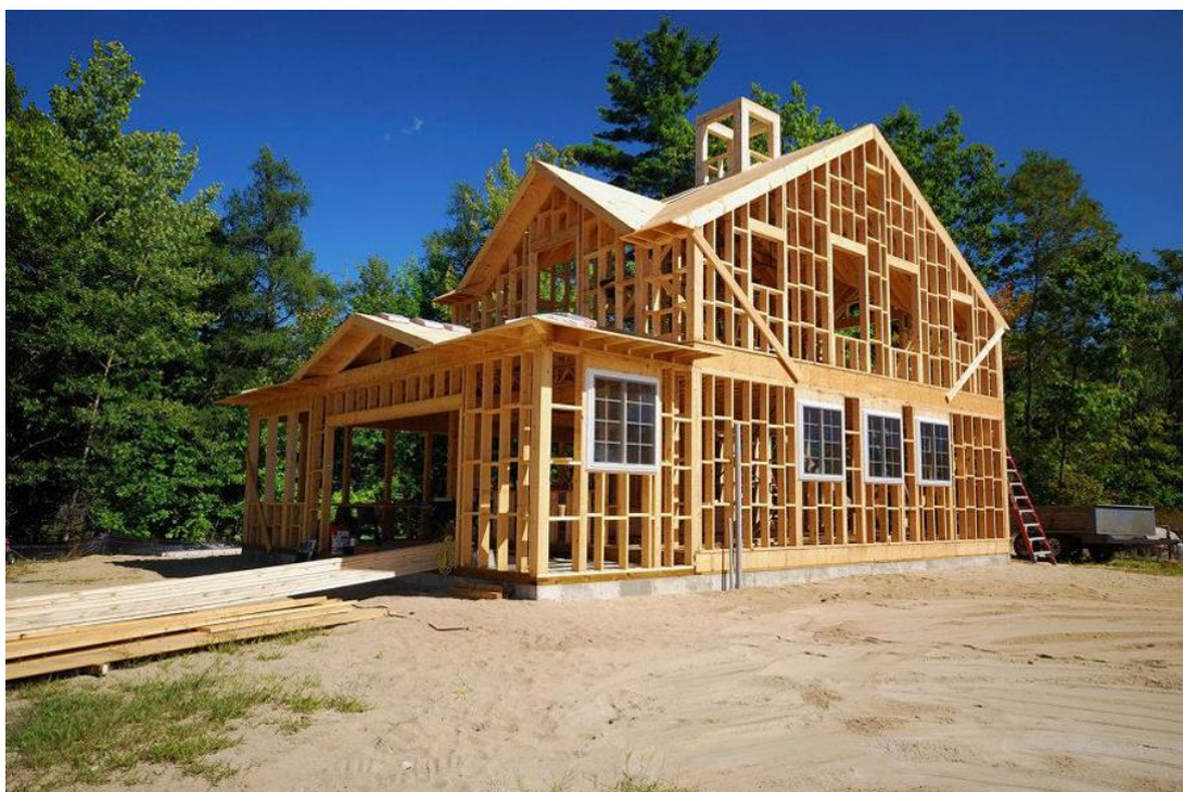
Figura 9 - Casa em Estrutura Wood Frame.
