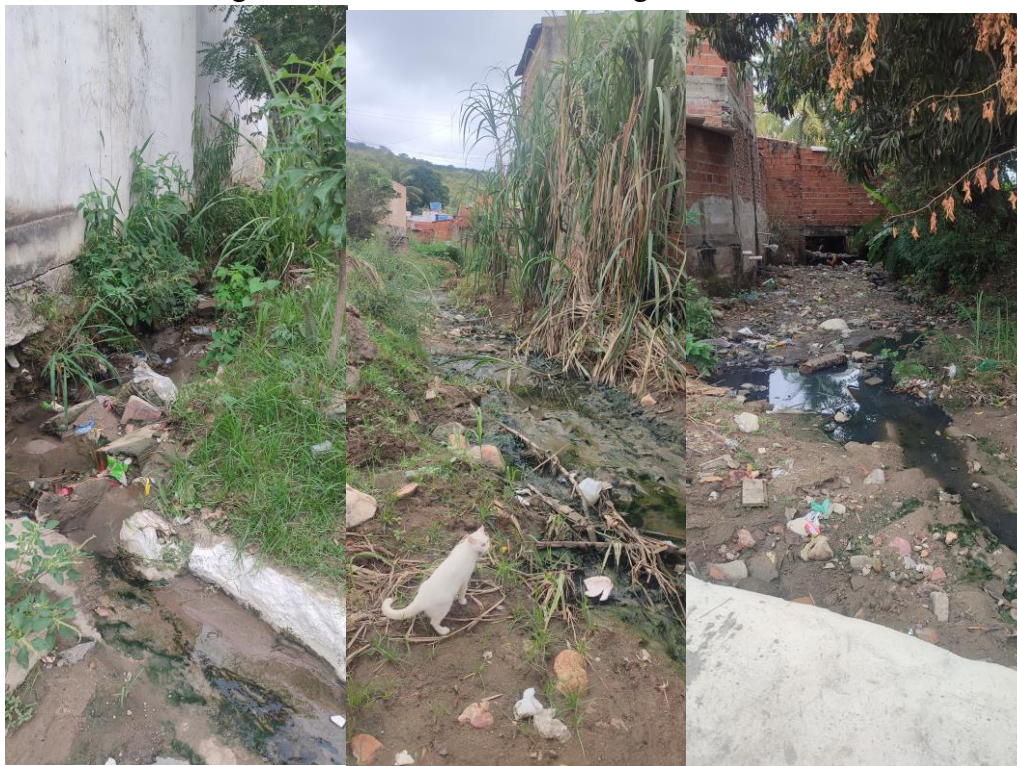
Figura 17 – Resíduos sólidos e esgotamento a céu aberto
